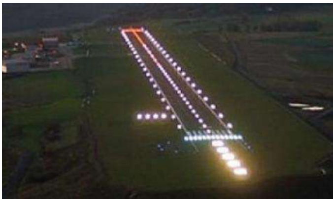
Figura 1.15. Luces de pista
