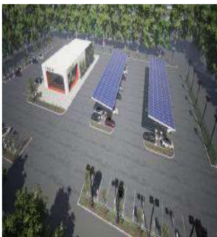
Figura 2.1 Estación de energía eléctrica
