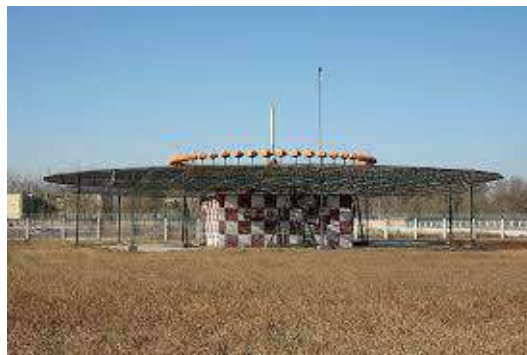
Figura 2.5. Instalaciones de un VOR en tierra
